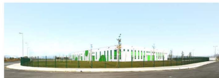
Vista esterna dell'edificio industriale
