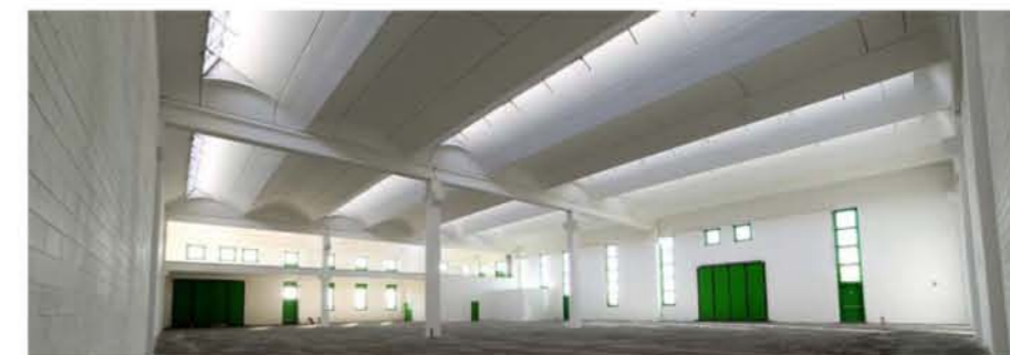
Vista interna - Area Magazzino Soppalco
